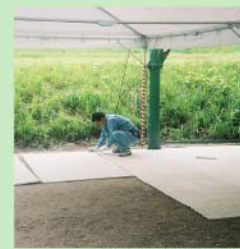
テント内バス設置風景
